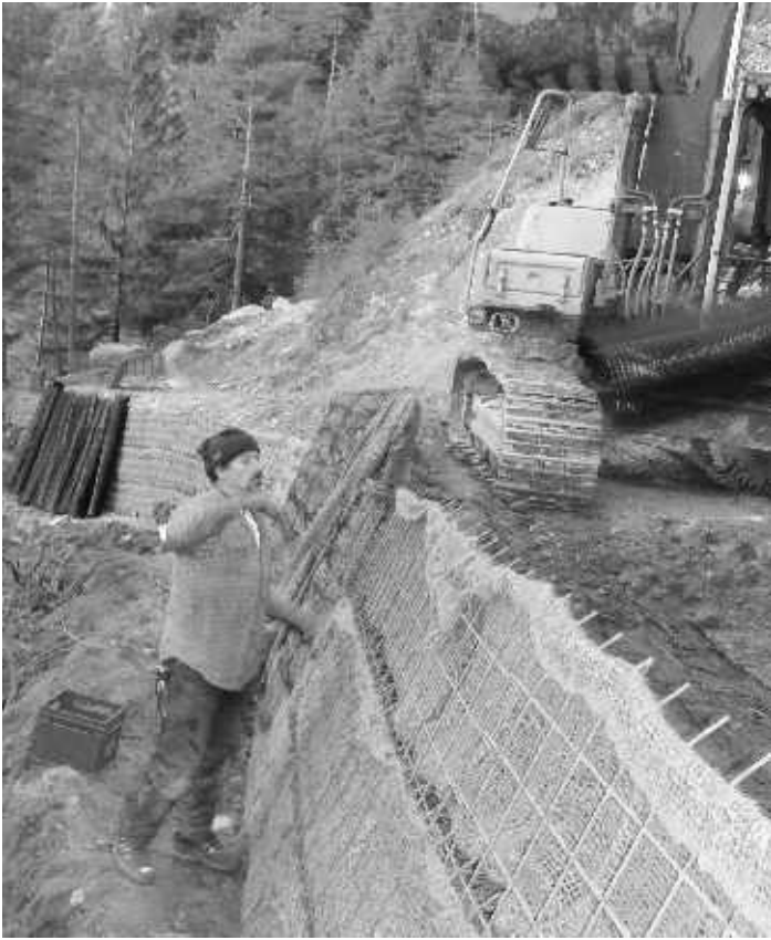
Herstellung einer Böschung mit Geogittern.
