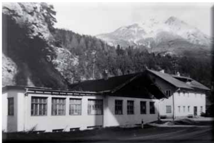
Betriebsgebäude der Wagnerei Reheis (Aufnahme aus der Dorfchronik)
